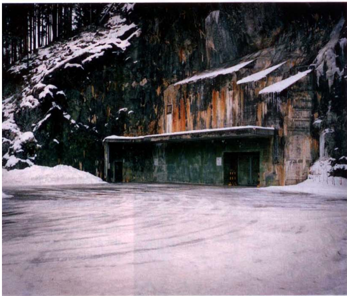
CAMOUFLAGE Swiss Fort Knox a conservé son aspect de blockhaus inséré dans la roche. Il était auparavant occupé par l'armée de l'air.
