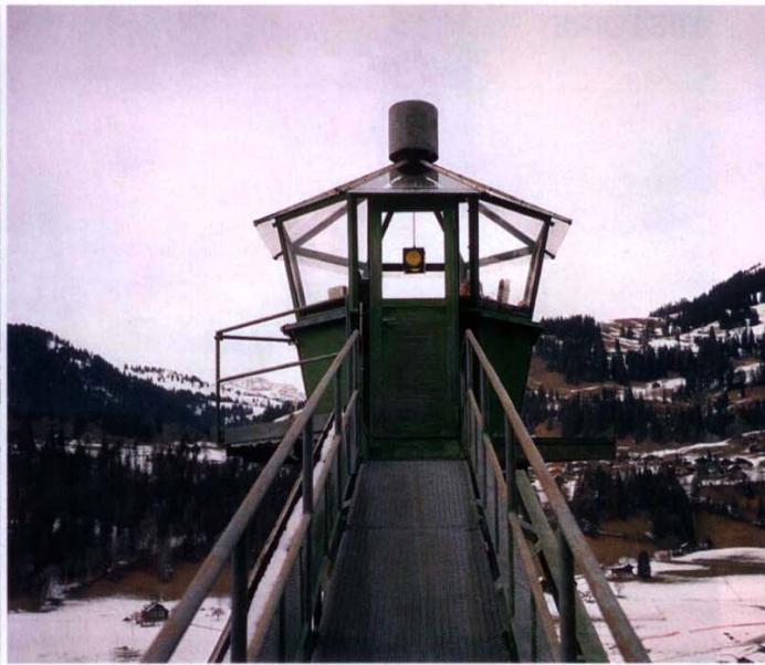
MIRADOR C'est dans ce « sky bar » que sont signés les contrats de plusieurs centaines de milliers d'euros...
